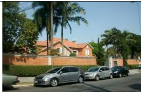
Fachada pela Rua Argentina
