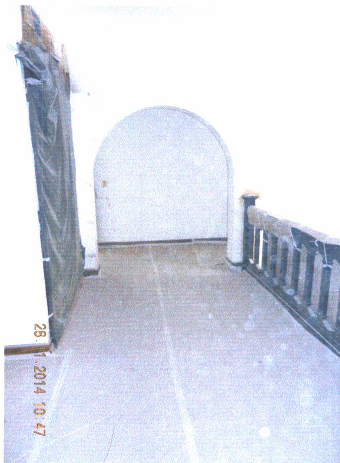
Detalhes Internos – Pavimento Superior
